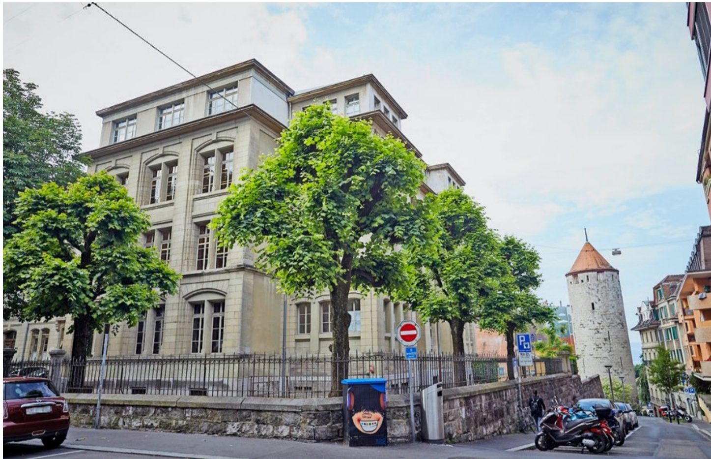
Saint-Roch sera bientôt restauré. Le collège fait partie des gros chantiers à venir. ODILE MEYLAN/A
